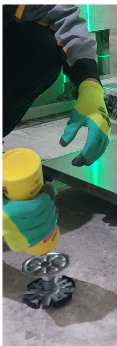
На опоры наносится морской клей
